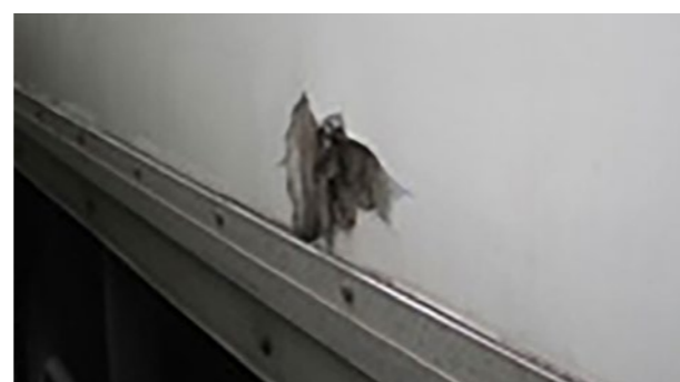
Drevené bočné panely: poškodená drevená podpera \geq 20 cm
