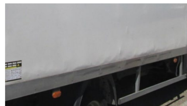
Laminátové bočné panely: deformácia v spodnej časti, dĺžka > 1 m Pozn.: výmena predného panela podvozka si vyžaduje demontáž podvozka.
