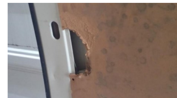
Vnútorne drevené ochranné obloženie: stopy po náraze, rozbitý panel, chýbajúci panel (okrem horných panelov dverí)
