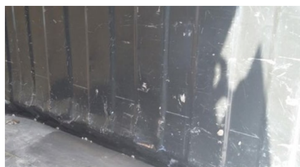
Vnitřní deformace: mírná deformace bez perforací nebo promáčklín, doba opravy ≤ 3 h
