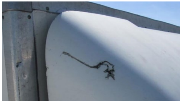
Kabina a deflektor: v rámci ekonomičnosti opravy
