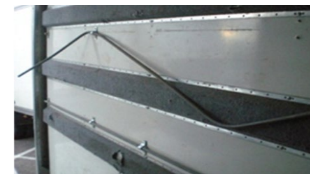
↻ Čalounění a profily: tyče, upevňovací prvky, čalounění – chybí nebo je deformováno nad rámec ekonomičnosti opravy
